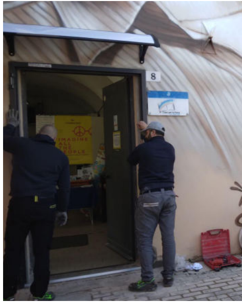
Casa della Pace: nuovo portone e manutenzione dei pilastri
