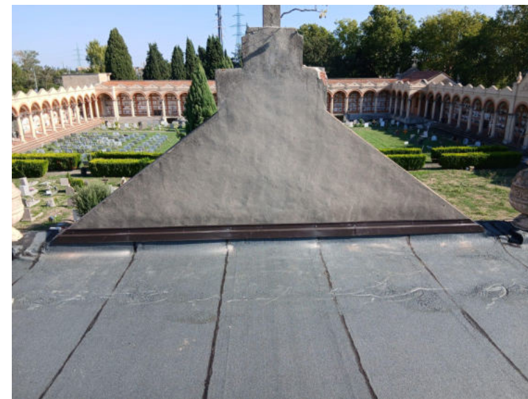
Ripristino coperto zona storica
