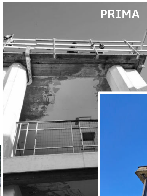
Ripristino coperti zona nuova (mese di ottobre)
