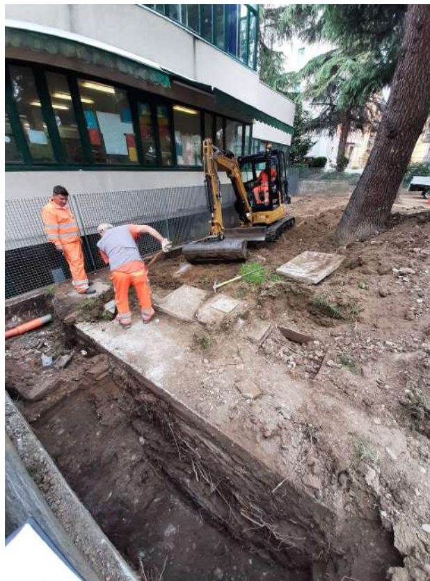
Ripristino reti fognarie
