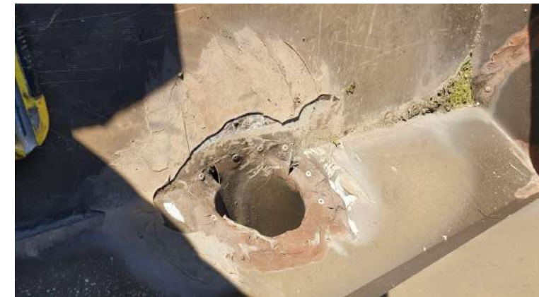
Ripristino locale delle impermeabilizzazioni
