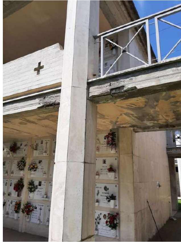
Ripristino locale delle impermeabilizzazioni
