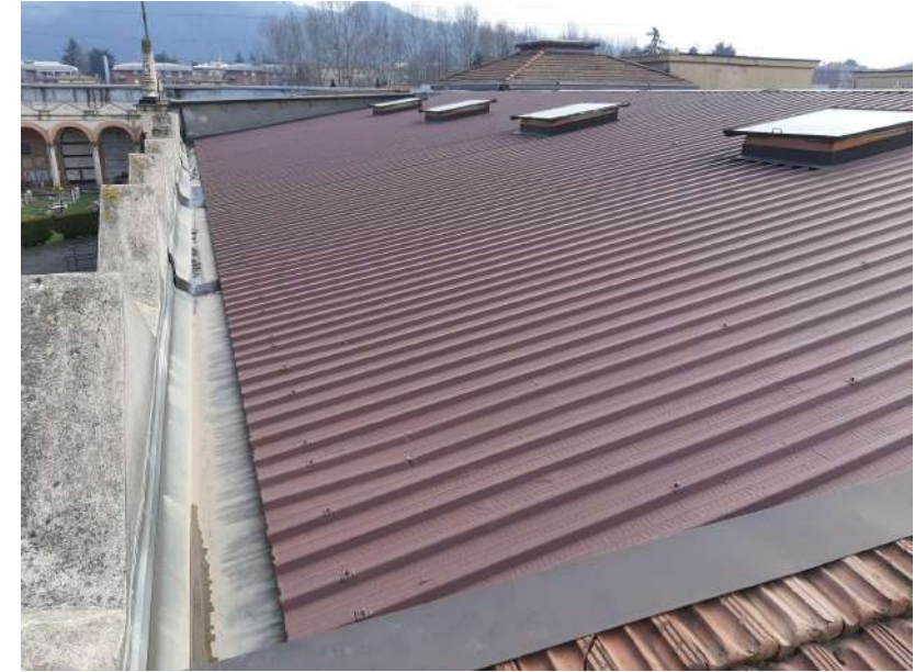
Ripristino locale delle impermeabilizzazioni
