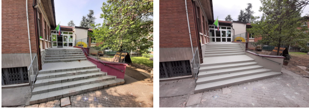
Scuola dell'infanzia Vignoni: manutenzione scalinata principale e secondaria
