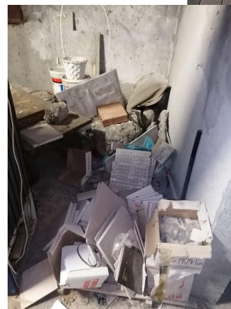
Avvio delle operazioni di recupero e riqualificazione del magazzino esterno (lato ferrovia)
