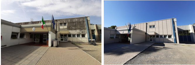
Scuole Ciari Riqualficazione delle facciate e degli infissi esterni
