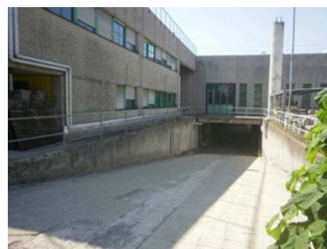
Rampa di accesso al magazzino interrato
