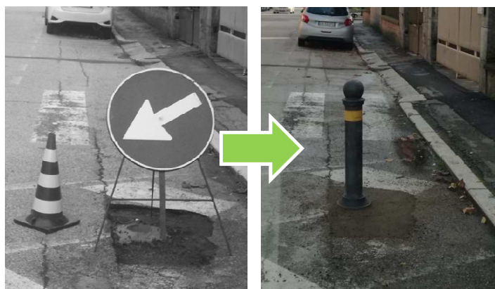
installazione arredo urbano
