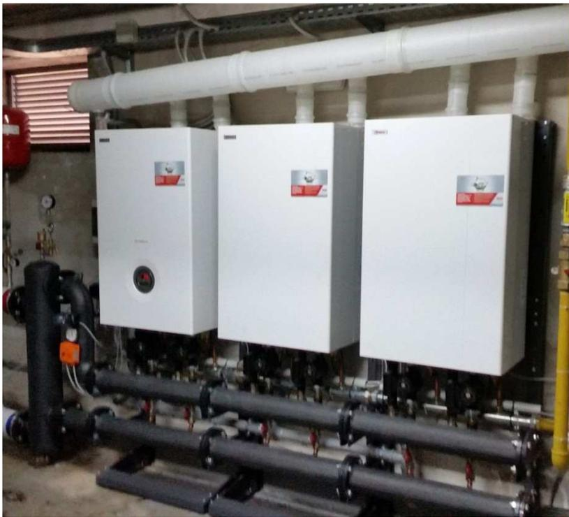
All'interno della Centrale Termica della Casa della Conoscenza è stata sostituita la vecchia Caldaia a Condensazione con una nuova caldaia modulare.
